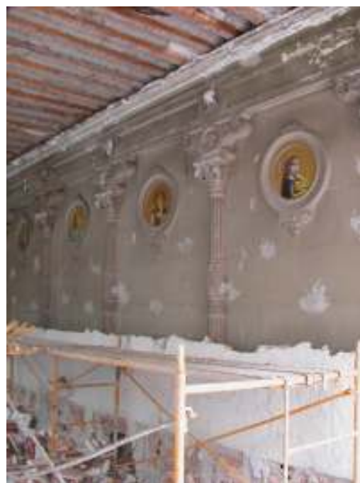
Proceso de demolición de muro que ocultaba el paramento original en muro medianero con la nueva cruja del palacio.
