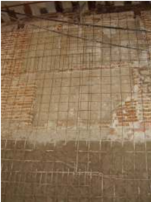
Refuerzos / cosido de muros en sala de Prensa PB
