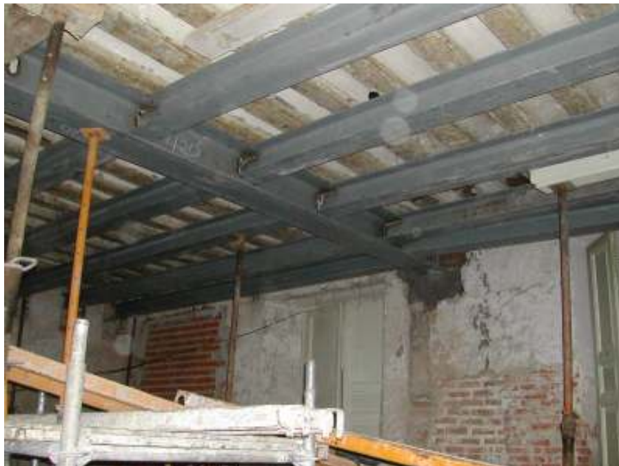
Refuerzo mediante estructura metálica de forjado de Comedor Beistegui sobre nueva cocina.
