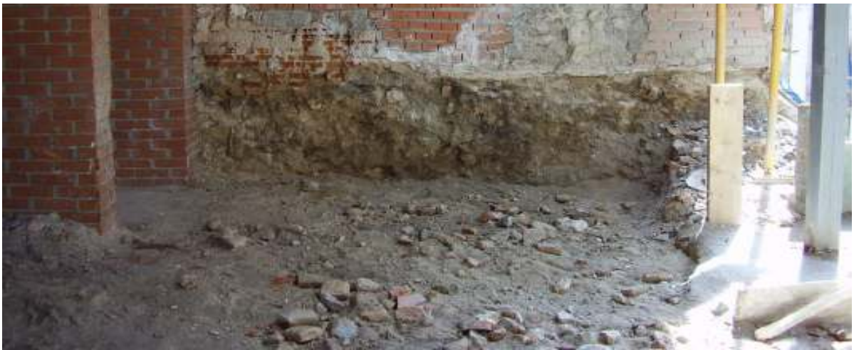
Cimentaciones de cal y canto en Salón de Rivas PB.
