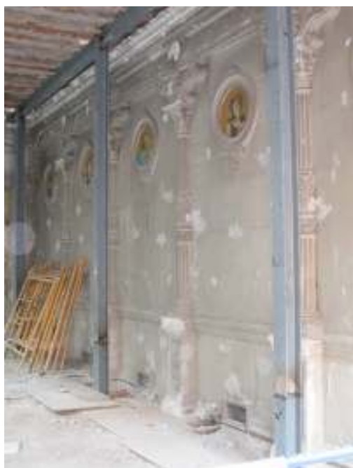
Detalle de los dos muros que forman parte del Claustro ocultos tras muros de fábrica.
