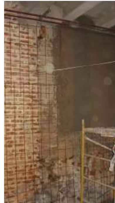
Refuerzos / cosido de muros en sala de Prensa PB
