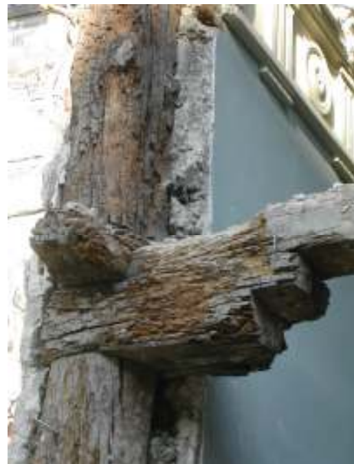
Muro entramado de la fachada posterior del Palacio hacia el jardín y detalle de su estado.
