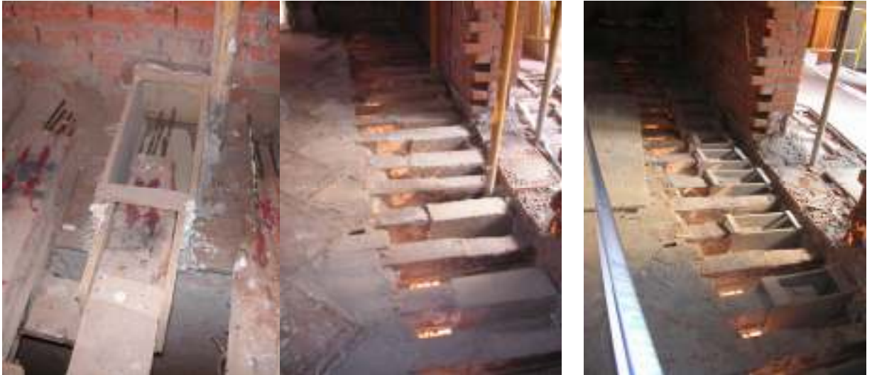
Detalle de restitución de entregas de viguetas de madera en Planta primera con resinas.
