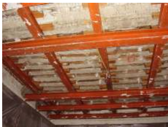
Ignifugado de mortero de vermiculita sobre forjado de madera de Despacho de Ministro en planta principal reforzado con estructura metálica.
