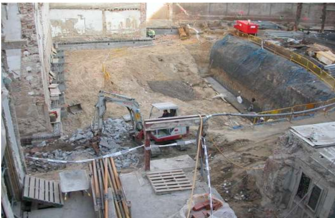
Vista general del vaciado del Edificio del Ministro con la pantalla de micropilotes a la izquierda.
