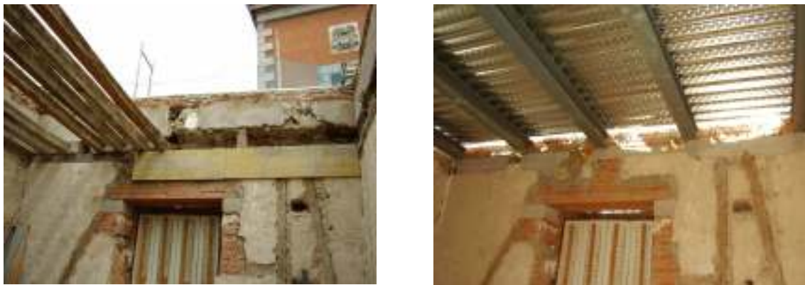
Demolición y ejecución de nuevo forjado metálico en Torreón Norte
