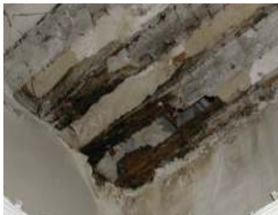
Forjados de madera de planta segunda en la 1ª crujía de Concepción Jerónima
