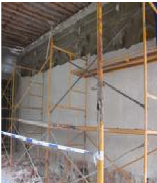
Proceso de demolición de muro que ocultaba el paramento original en muro medianero con la nueva cruja del palacio.
