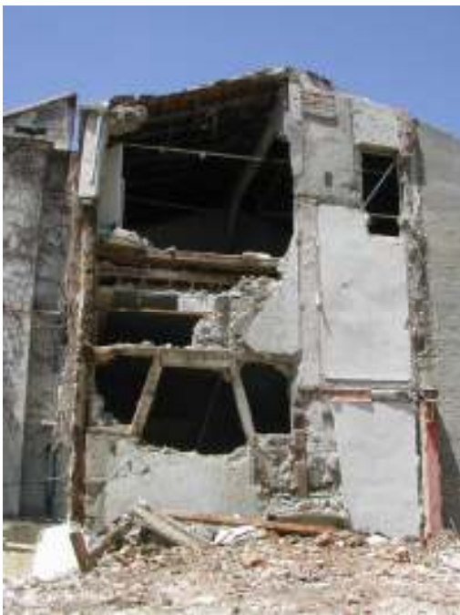
Muro entramado de la fachada posterior del Palacio hacia el jardín y detalle de su estado.
