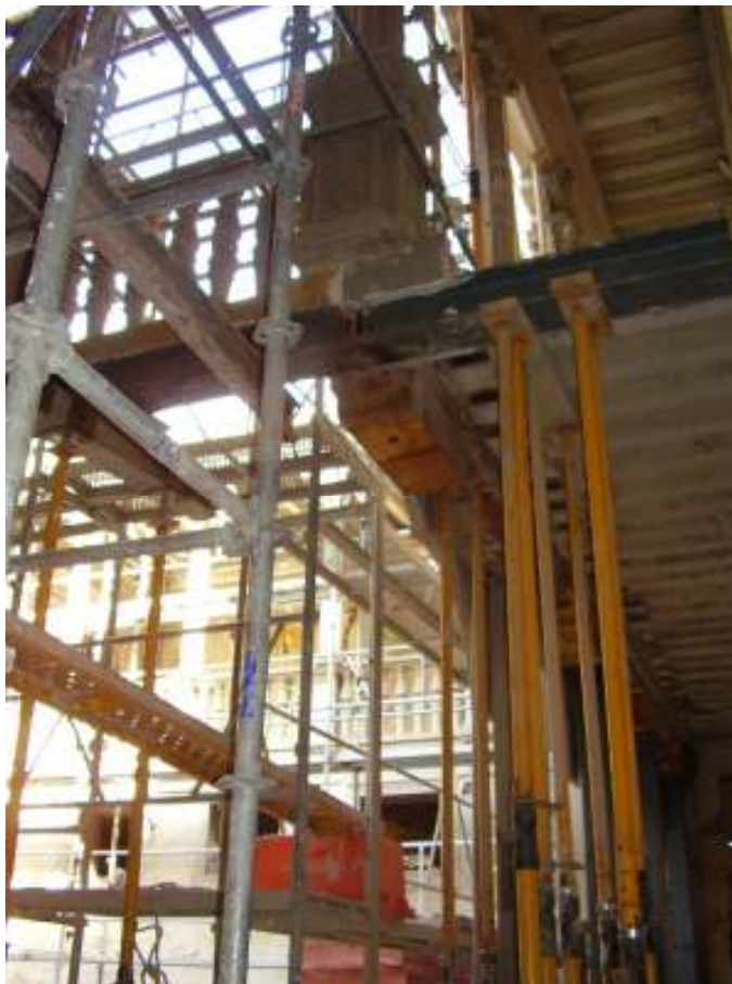
Detalle de apeos y sustitución estructural de la planta baja del Patio de Rivas
