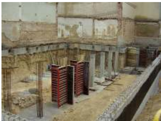
Pantalla de micropilotes y maquinaria en ejecución.
