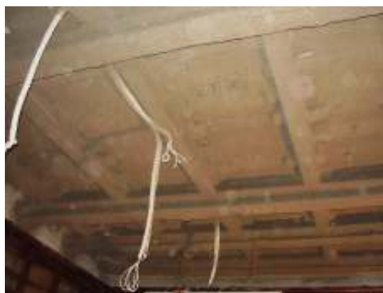
Ignifugado de mortero de vermiculita sobre forjado de madera de Despacho de Ministro en planta principal reforzado con estructura metálica.
