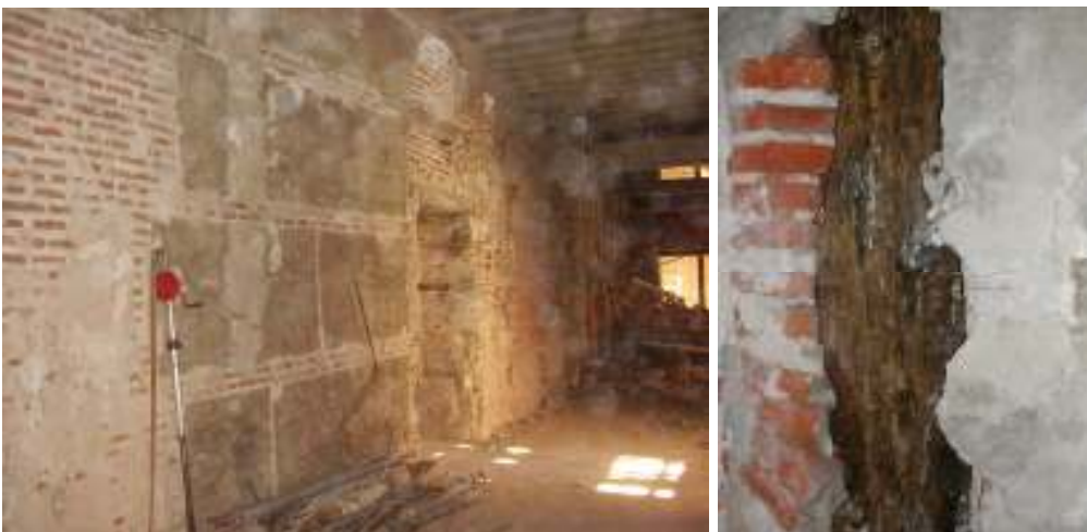
Muro sala de prensa en planta baja palacio.
